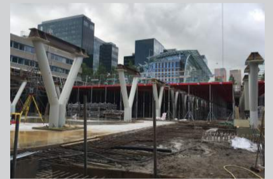
Uitzetwerkzaamheden bij station Amsterdam Zuid
